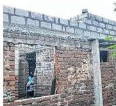
Das Haus soll renoviert werden.
